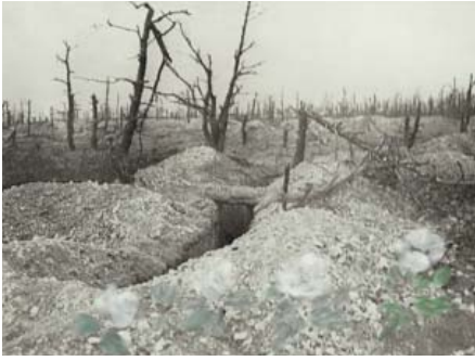
Premier Noël dans les tranchées
